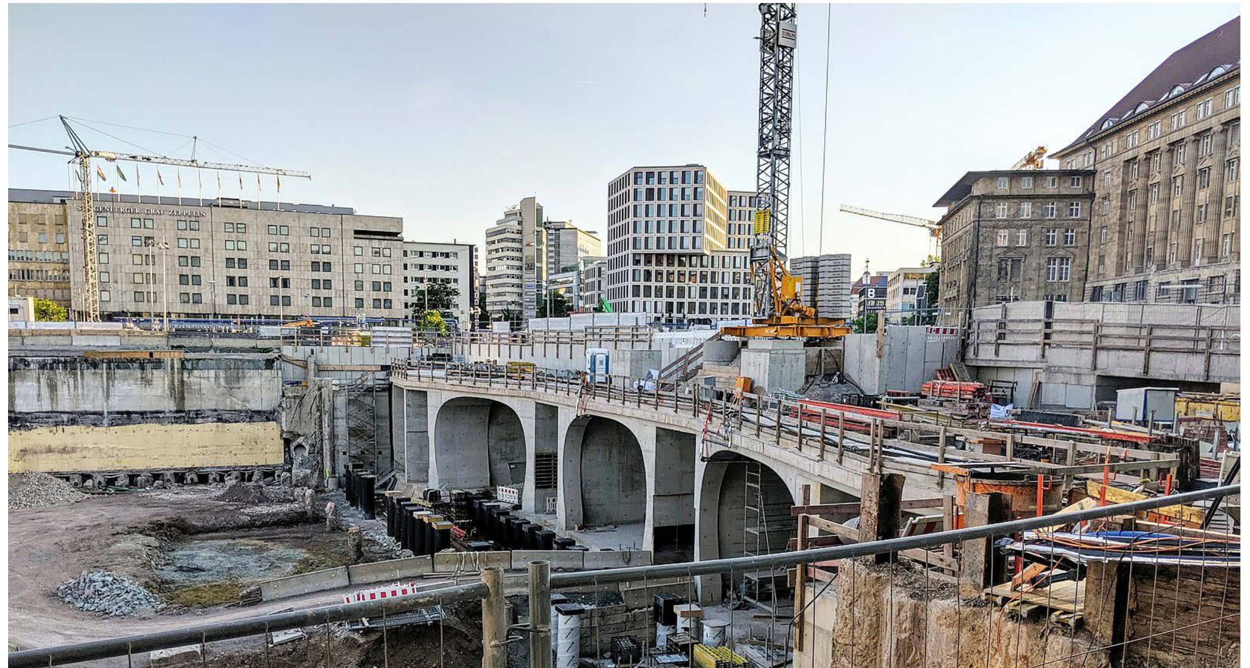
06. Dktue: „Baustelle Stuttgart 21“, https://commons.wikimedia.org/wiki/File:Baustelle_Stuttgart_21_gesehen_vom_Karoline-Kaula-Weg_Blickrichtung_Sudwesten.jpg , 09.10.2020
